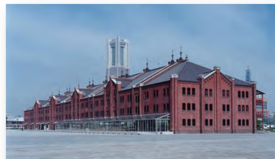
横浜赤レンガ1・2号館倉庫改修 (2001年)
