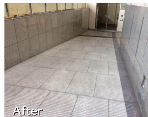
スロープ ノンスリップ溝切加工
